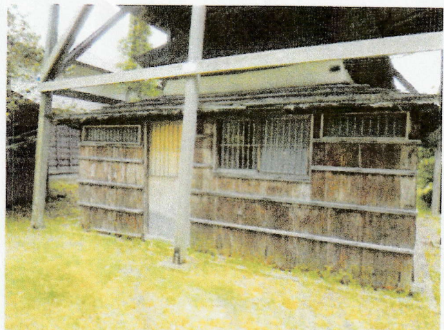
外壁・保護舎
